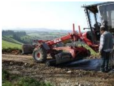
Pose du géotextile
