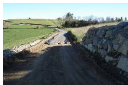
Mise en place du gravier
